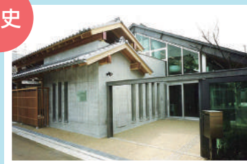
● 八尾市まちなみセンター
