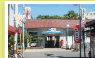
平成19年の八尾駅舎(南口)。
