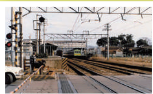
渋川踏切から駅舎を望む(昭和)。
