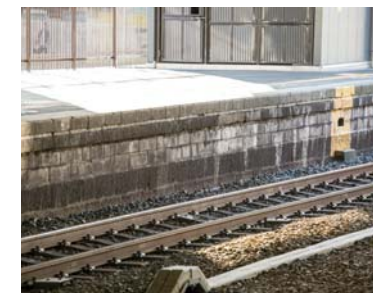
開業して125年以上経過したプラットフォームは、停車する車両に応じてかさ上げしてきた
